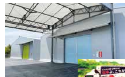
新設した倉庫
